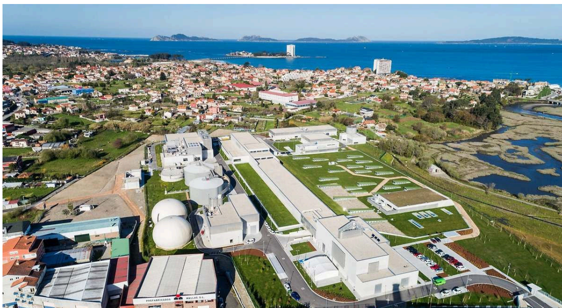
EDAR de Lagares operada por GS Inima
